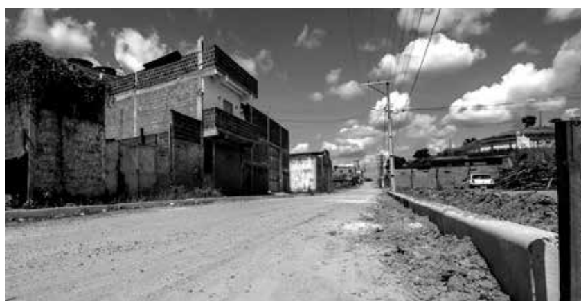
Saneamento no Bairro Santa Clara
