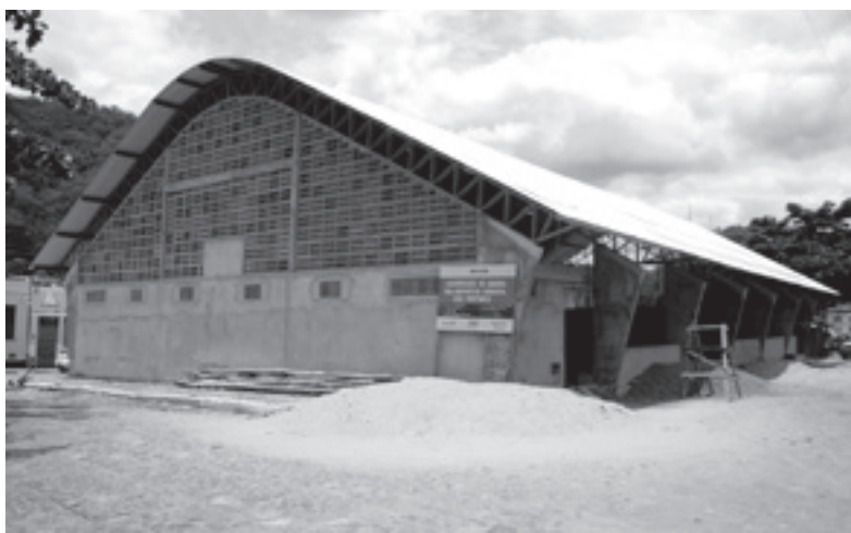
Quadra coberta de Banco Central está em fase de conclusão, em Ilhéus
