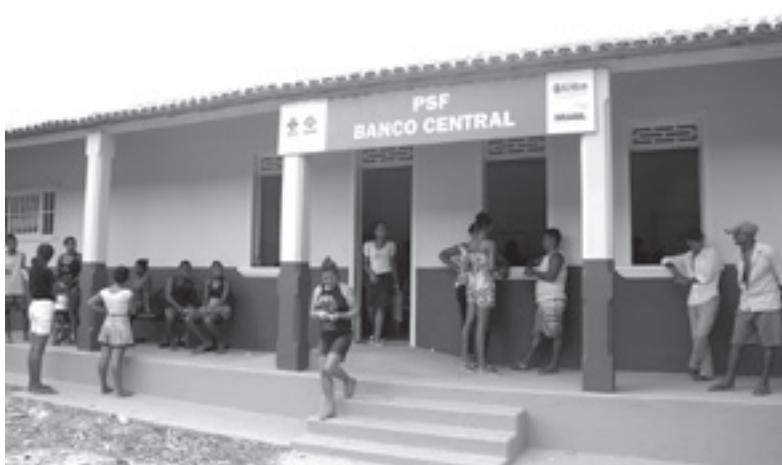
Posto de Saúde de Banco Central, em Ilhéus, foi reformado e ampliado
